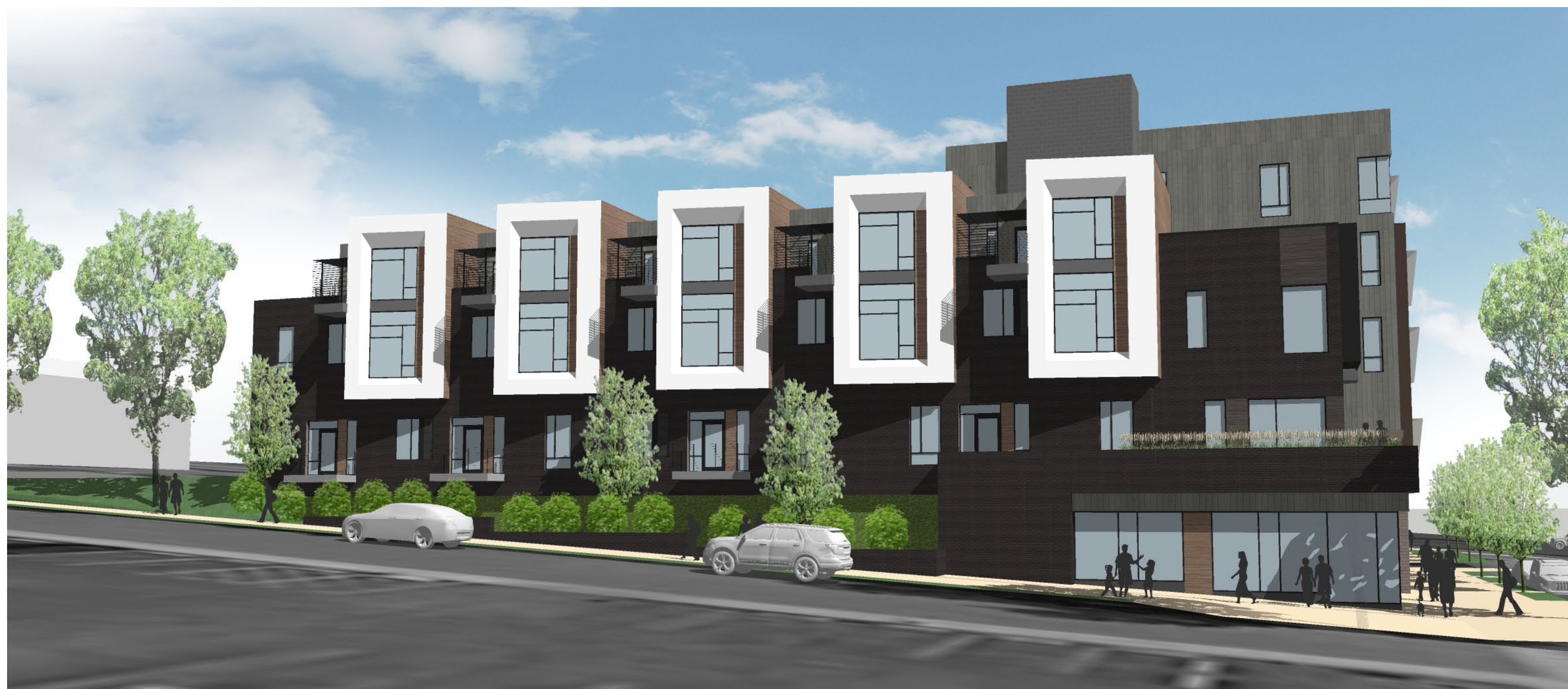
N. GROVE ST. LOOKING EAST
