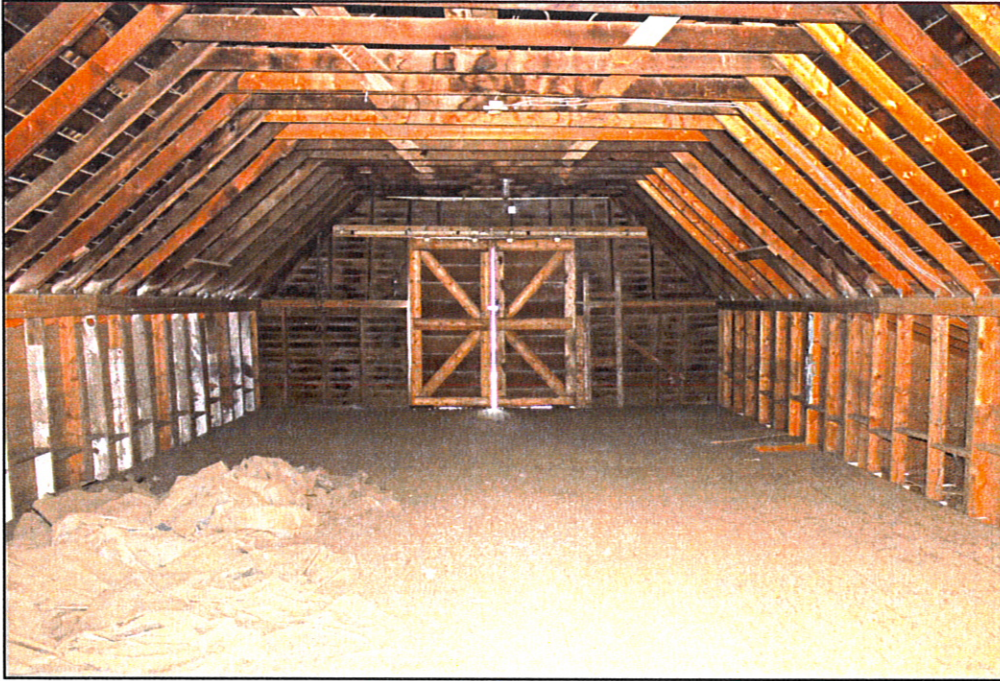
Barn Interior, Hayloft (fig. 13)
