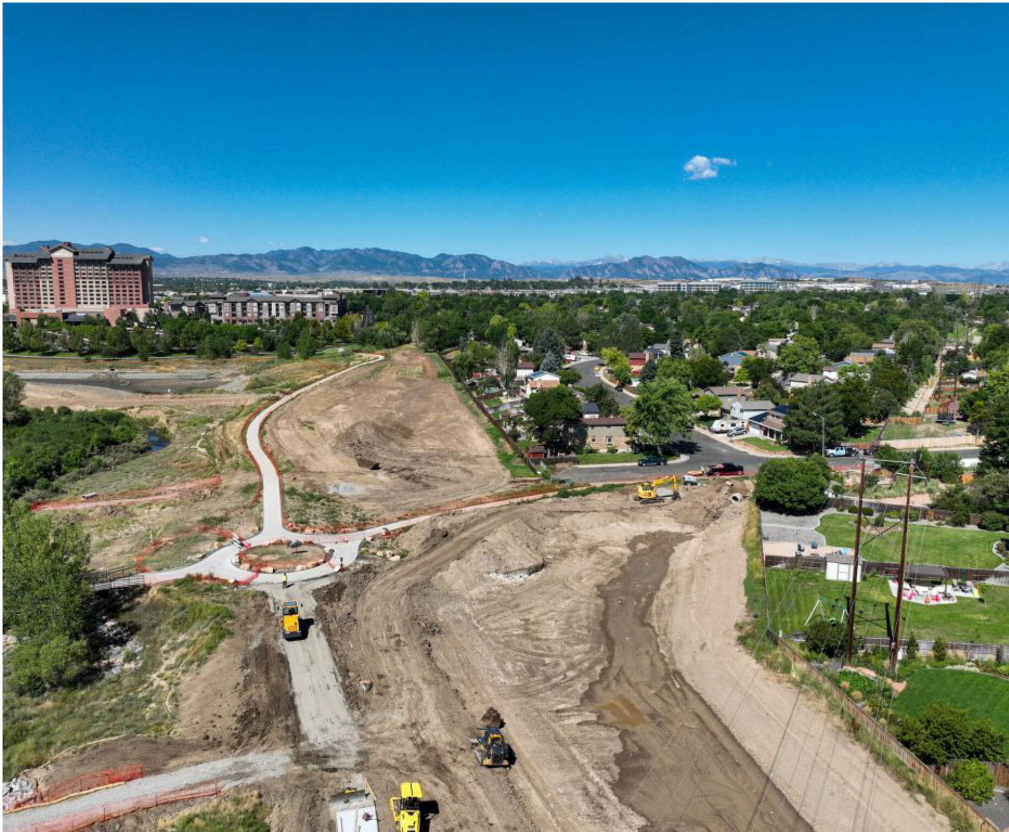
Construction of two new stormwater quality dry ponds (west and east of roundabout). Construcción de dos nuevos estanques secos de calidad para aguas pluviales (al oeste y al este de la rotonda).
