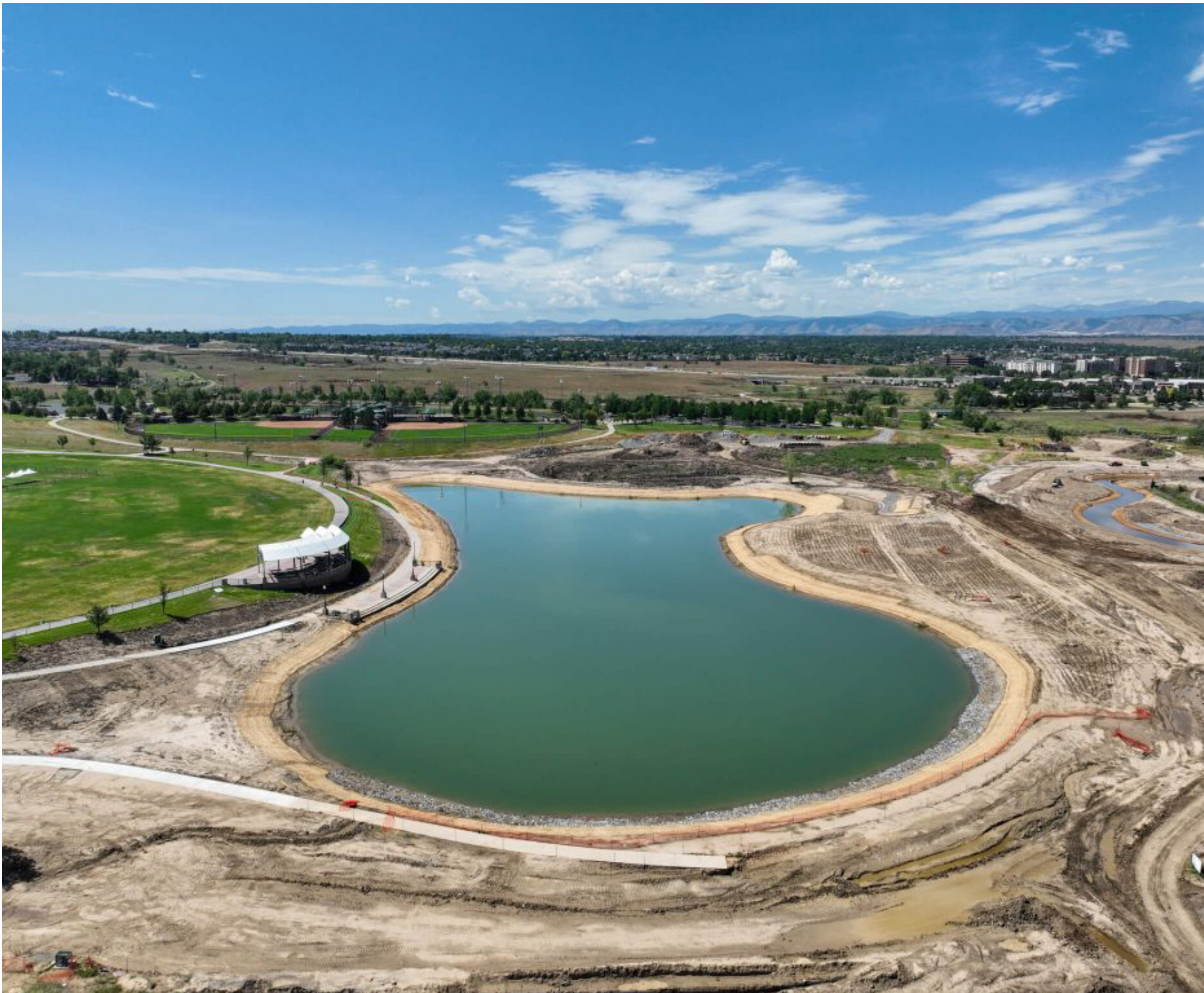
City Park Pond Improvements – dredged accumulated sediment from reclaimed water pond. Lined pond to prevent loss of water to infiltration. Pond banks will be revegetated. Mejoras en el estanque del parque municipal - dragado de los sedimentos acumulados en el estanque de agua regenerada. Estanque revestido para evitar la pérdida de agua por infiltración. Las orillas del estanque se revegetarán.
