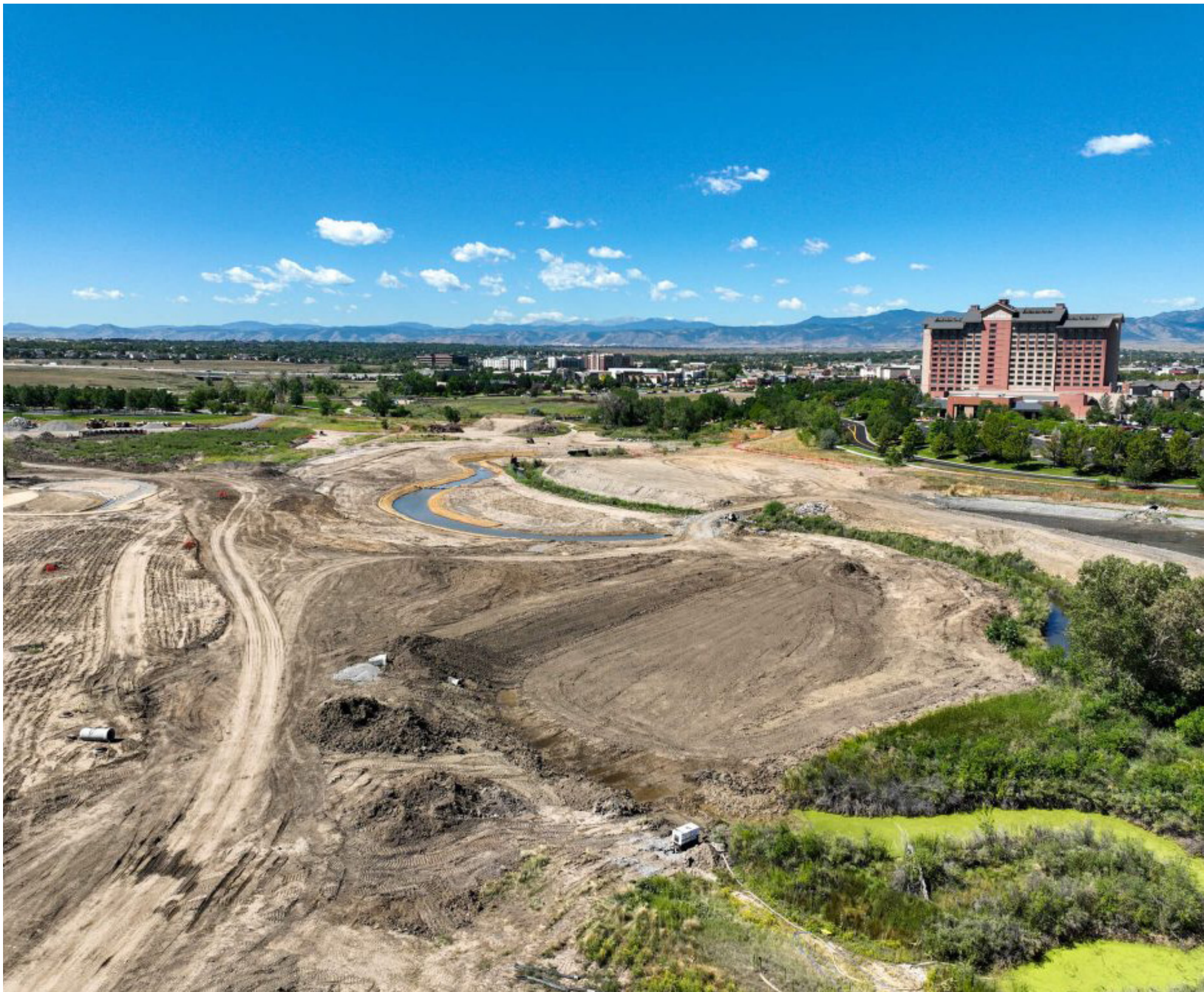
Construction of new stabilized stream segment. Big Dry Creek will be routed to this new area to add natural curves/bends back into the creek. Construcción de un nuevo segmento de arroyo estabilizado. El Big Dry Creek se desviará hacia esta nueva zona para devolverle sus curvas naturales.
